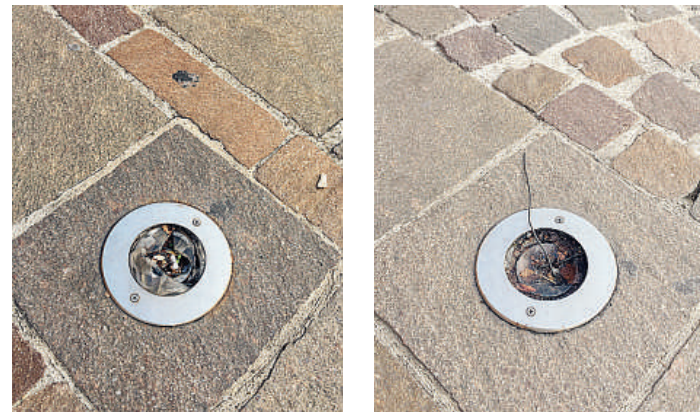
Nell'area pedonale di piazzale Libertà i faretti a terra con rotta la copertura
